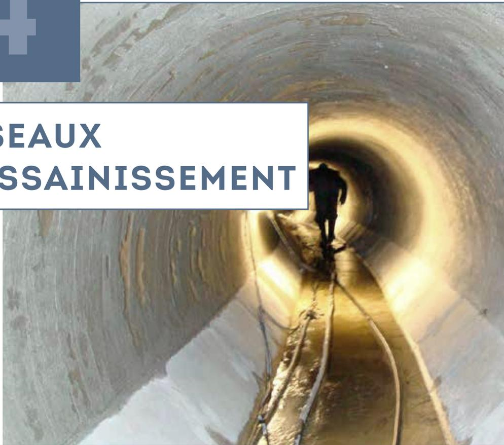
Les réseaux d'assainissement en béton ou en maçonnerie enterrés (canalisations, stations, réservoirs, postes de relevages...) sont soumis à un grand nombre d'actions d'ordre mécanique : poids propre, poids de l'effluent, charges dues aux remblais, charges de surfaces et chimiques :  $H_2S$ , sulfates, lixiviation, bio contaminants... En service, ils vieillissent d'autant plus vite qu'ils subissent des agressions mécaniques et chimiques dégradant notablement leur efficacité.
