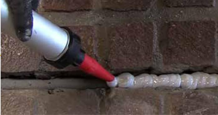
• **669 LANKOSOL JOINT** est un mastic monocomposant polyuréthane, adapté pour le calfeutrement de joints horizontaux et verticaux de dilatation, de retrait et de construction.
