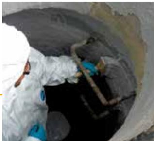
Éléments de liaison entre la surface et les réseaux enterrés, les cheminées sont soumises à des agressions tant mécaniques que chimiques.
