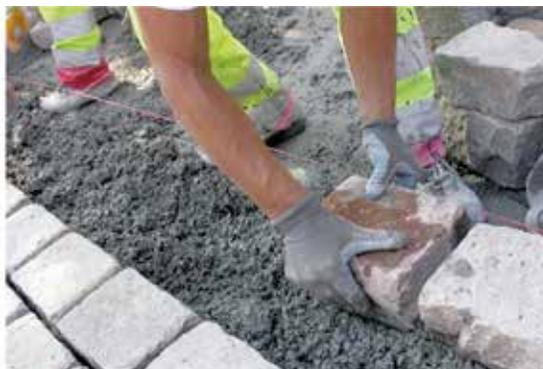
L'épaisseur du mortier doit être la plus uniforme possible et ne doit pas refluer de plus d'1 cm dans les joints (norme NF P98-335).
