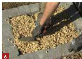
6 > Appliquer le mélange et le talocher à l'aide d'un outil trempé au 725 LANKODILPOX
